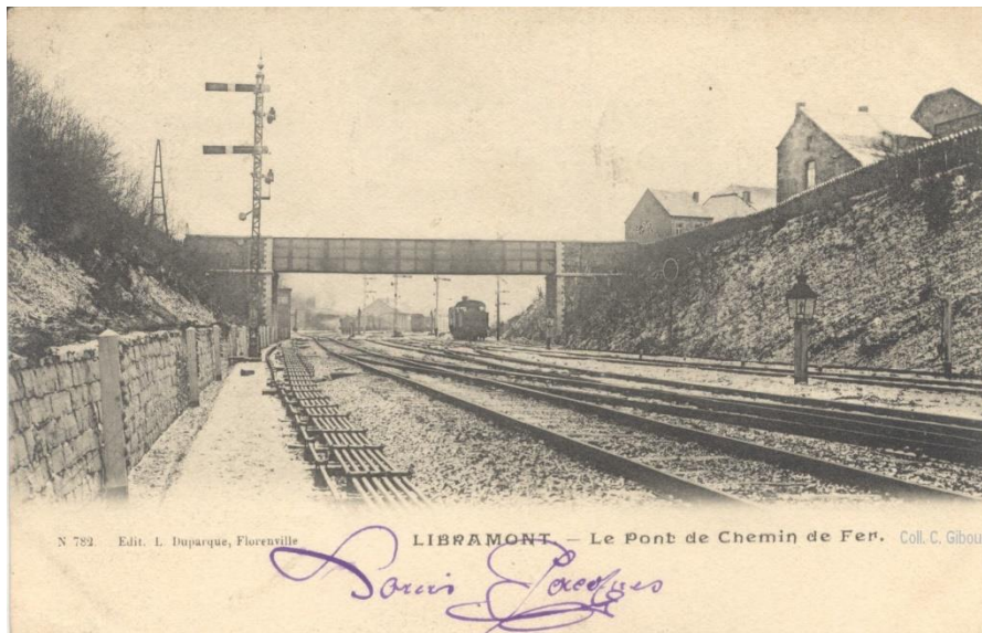
Figure 15: Libramont. Pont de chemin de fer. Avant 1914.
