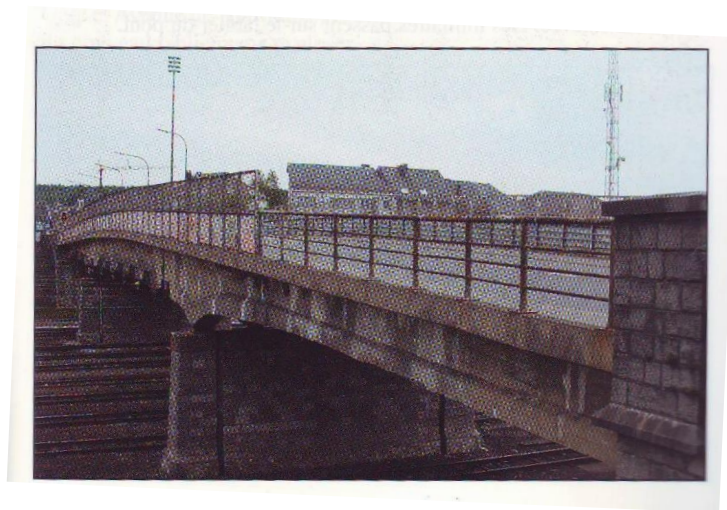
Figure 17: Libramont. Pont de chemin de fer. Avant 2009.
